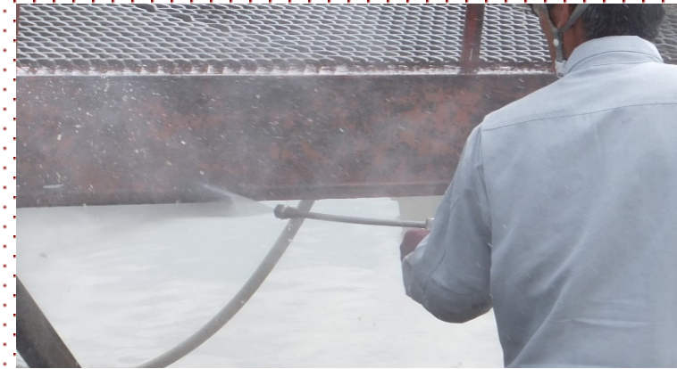
塩害を受けている塗装環境では、水洗が 必要になる場合があります。 水洗後は、多少湿っていても塗装可能
