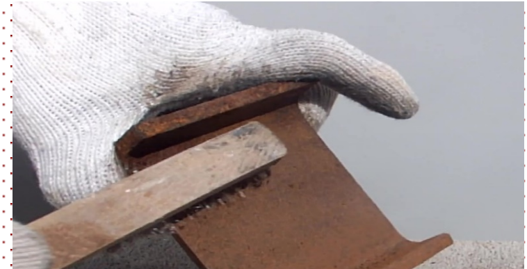
皮スキ、ワイヤーブラシ等で除去 （サビ層の目安は250μm以下）
